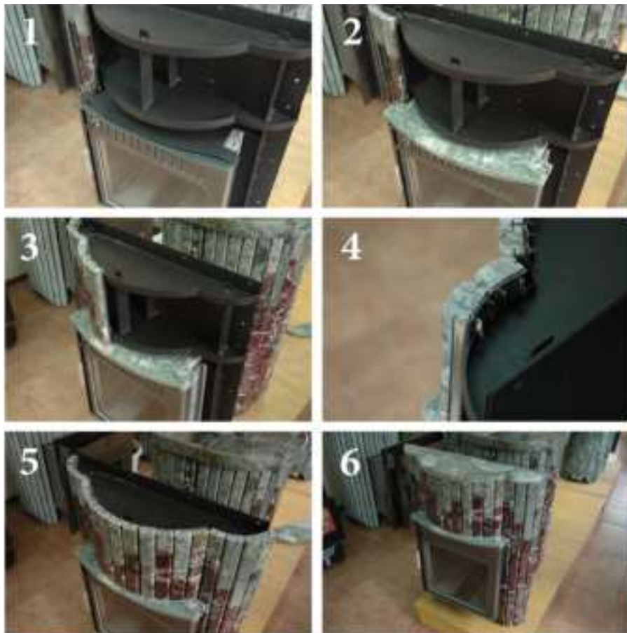
Рисунок 8.4.1. Схема установки ламелей и столешницы на портал печи.
